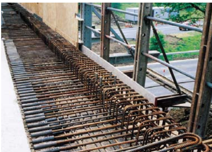
Manchons MBT alignés dans une dalle
