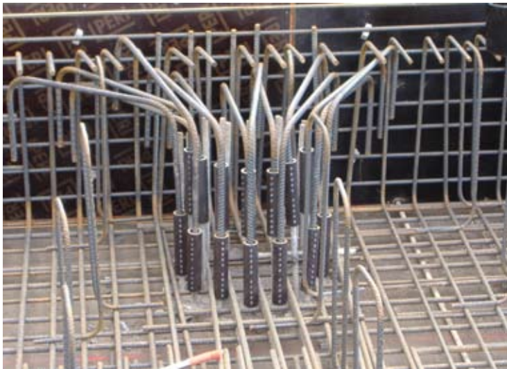
Haut de poteau avec des manchons MBT positionnés en décalage
